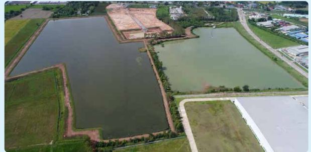
โครงการสร้างอ่างเก็บน้ำดิบเพิ่ม WHA SIL
