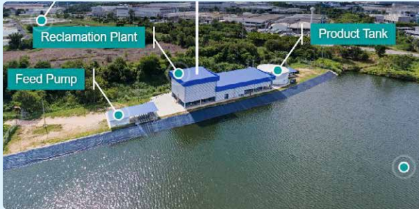
การจัดการความเสี่ยงจากภัยแล้ง Reclamation plant at ESIE
